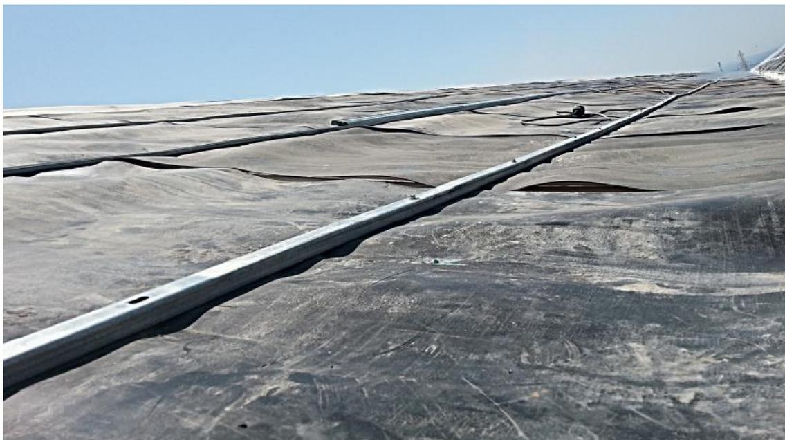
**Figura 46. Detalle de la ubicación de las láminas de polietileno negras opacas en el exterior de la cubierta del invernadero del tratamiento del 50% de sombra.**
