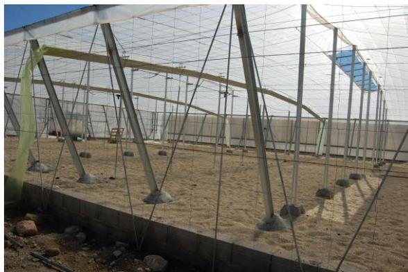
**Figura 9. Invernadero Raspa y Amagado en construcción**
