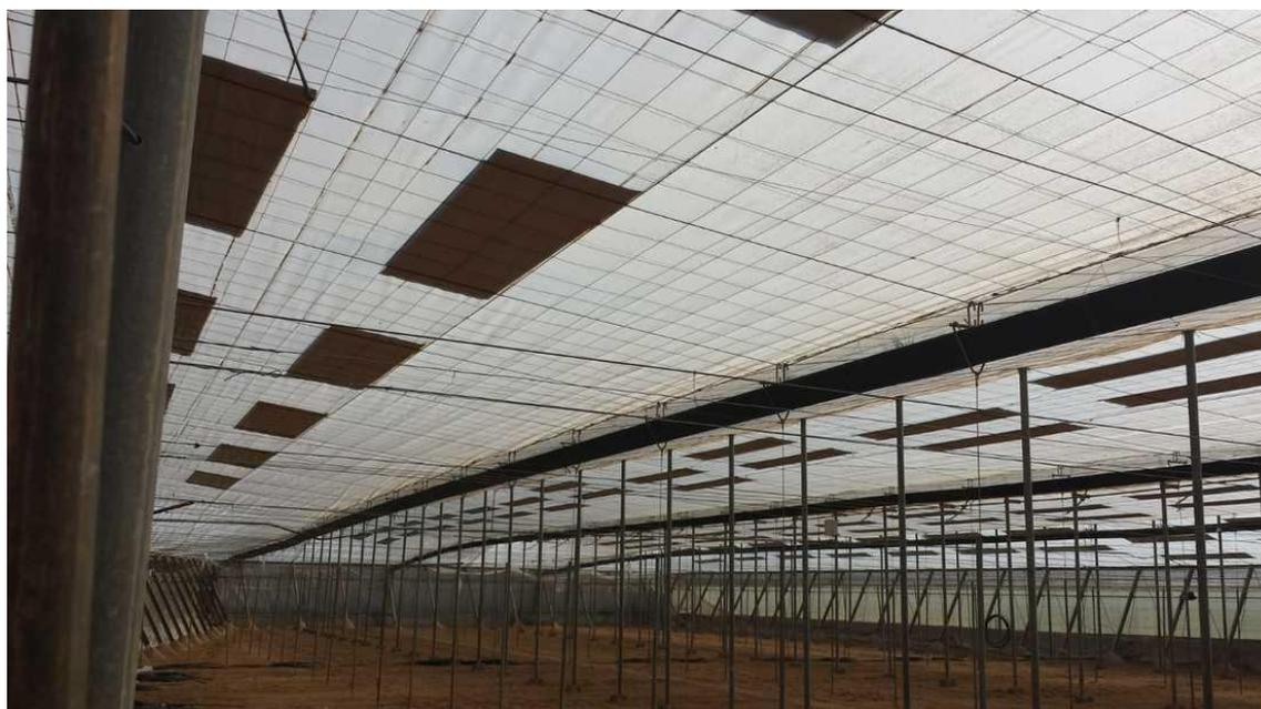
***Figura 35. Vista interna de invernadero comercial con cubierta fotovoltaica.
