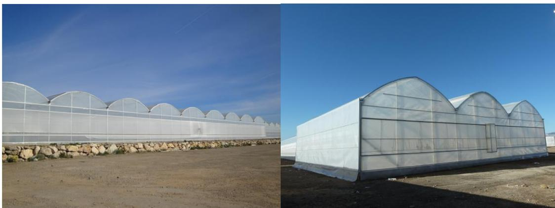
**Figura 12. Invernadero multitúnel semicircular (izq.) y ojival (dcha.)**
