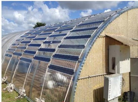
**Figura 29. Detalle de la disposición de las células fotovoltaicas en invernadero de túnel.**
