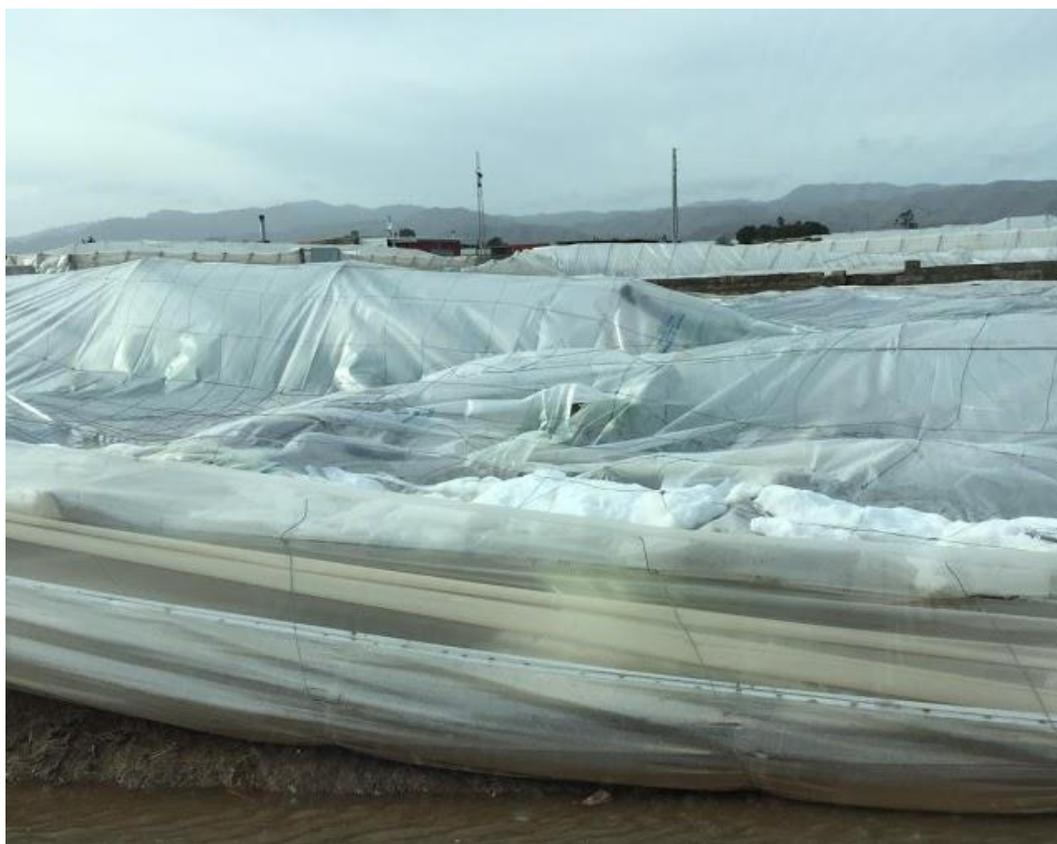
**Figura 10. Colapso de Invernadero tipo Almería por carga de granizo. Almería, enero 2020. Fuente: La Voz de Almería**
