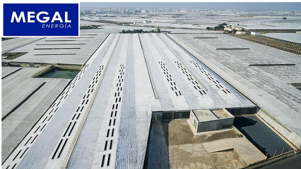
***Figura 34. Vista aérea de invernadero comercial con cubierta fotovoltaica.
