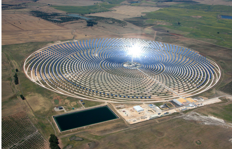
Figura 2.2: Imagen aérea de un sistema de receptor central en operación. Fuente: extraído de https://torresolenergy.com/gemasolar/ (Torresol Energy, 2020).
