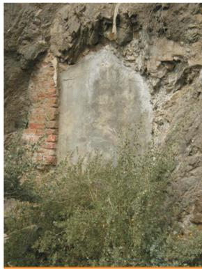
Figura 7.35. Cámara de condensación de humos de los hornos bajo la Torre de los Perdigos.
