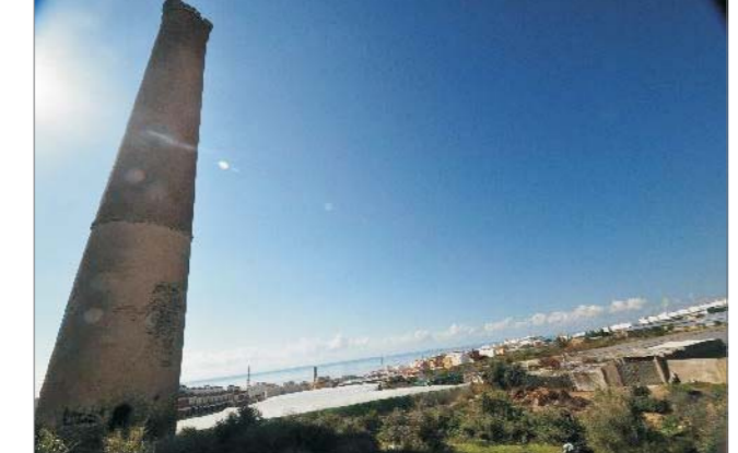
Figura 7.42. Torre del Humo y su entorno
