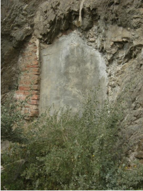
Figura 1.103. Detalle de la cámara de condensación bajo la Torre de los Perdigones en la actualidad.
