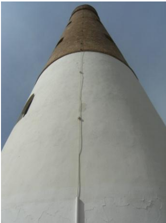
Figura 1.83. Detalle de la instalación de pararrayos de la Torre de los Perdigones en la actualidad.
