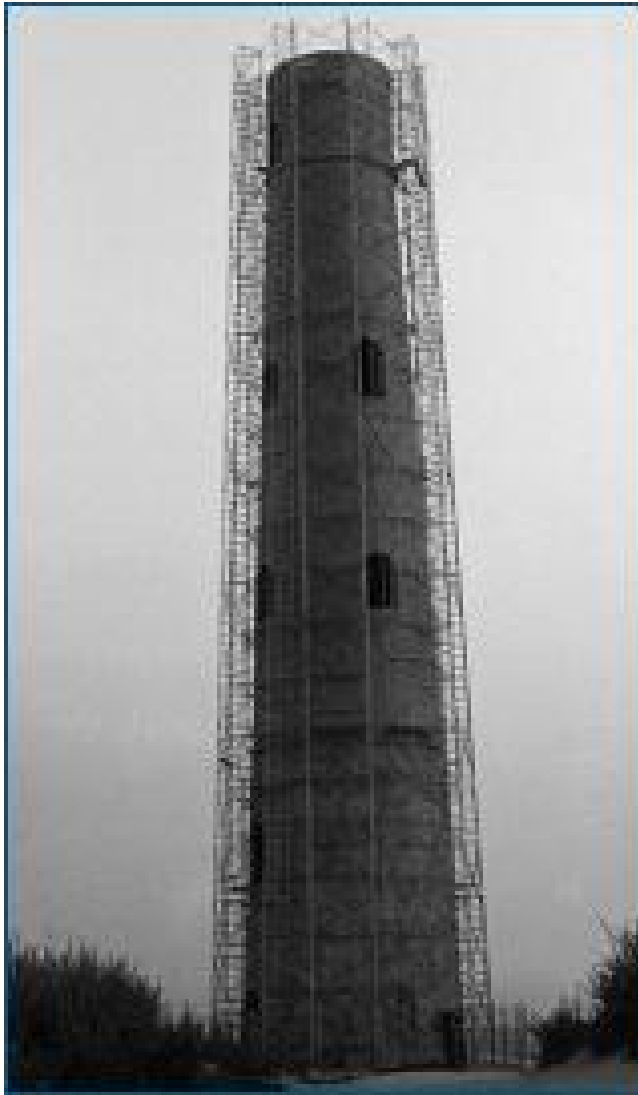
Figura 1.75. Torre de los perdigones mientras se realizaba su restauración. Proyecto de restauración de J.M. García, 1983.
