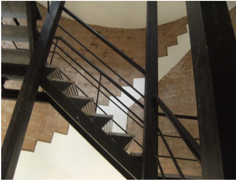
Figura 1.80. Escalera de la Torre de los perdigos respecto a la original en la actualidad.
