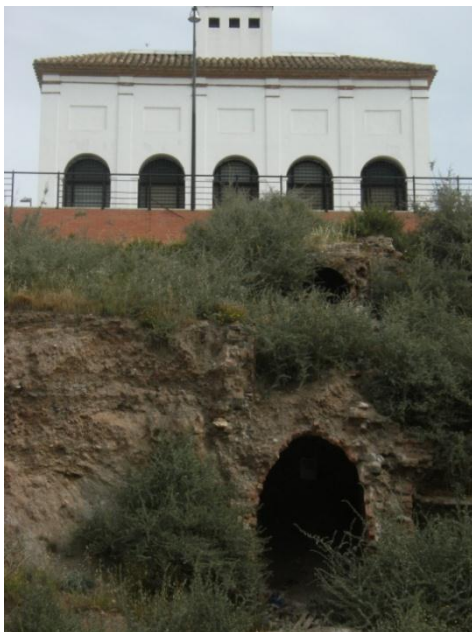
Figura 1.105. Imagen general de la cámara de condensación bajo la Fabriquilla del Vinagre en la actualidad.
