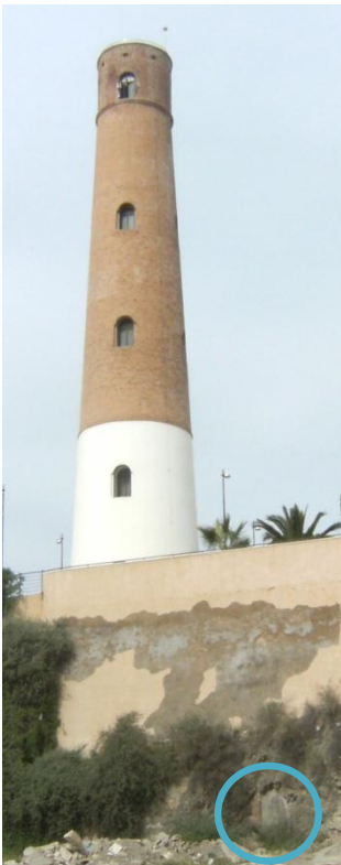
Figura 1.103. Imagen general de la cámara de condensación bajo la Torre de los Perdigones en la actualidad.
