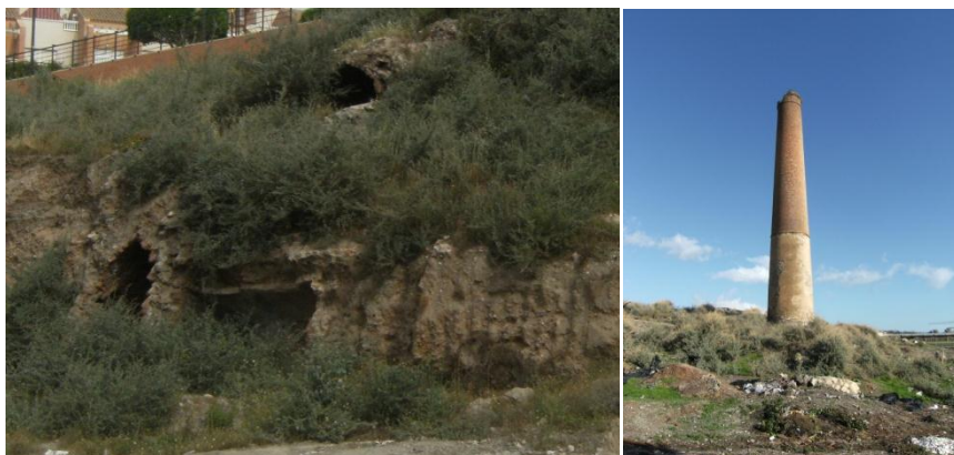
Figura 1.44. a) Cámara de condensación bajo Fabriquilla del Vinagre en la actualidad b) Torre del Humo en la actualidad
