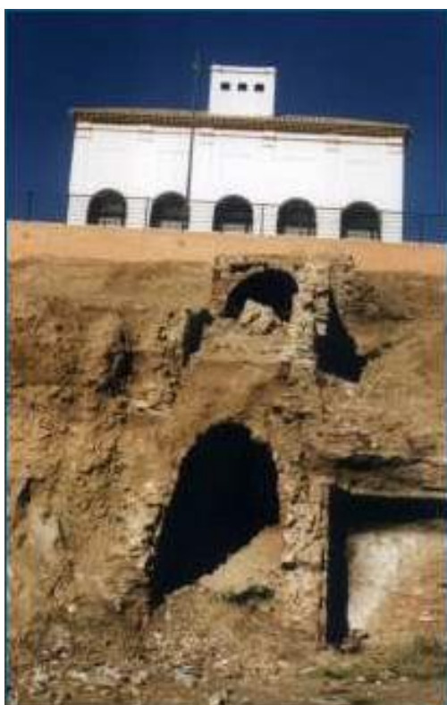
Figura 1.66. Túnel de evacuación de humos tóxicos excavado bajo la Fabriquilla del Vinagre y conectado con la Torre del Humo en la actualidad
