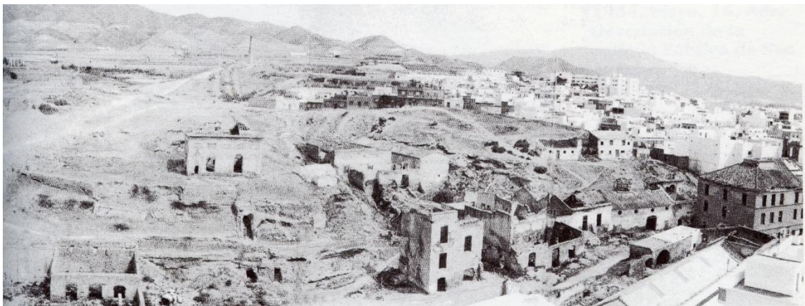
Figura 1.68. Ruinas de la fundación San Andrés de Adra, 1984 7 . Historia de Adra, 2006.
