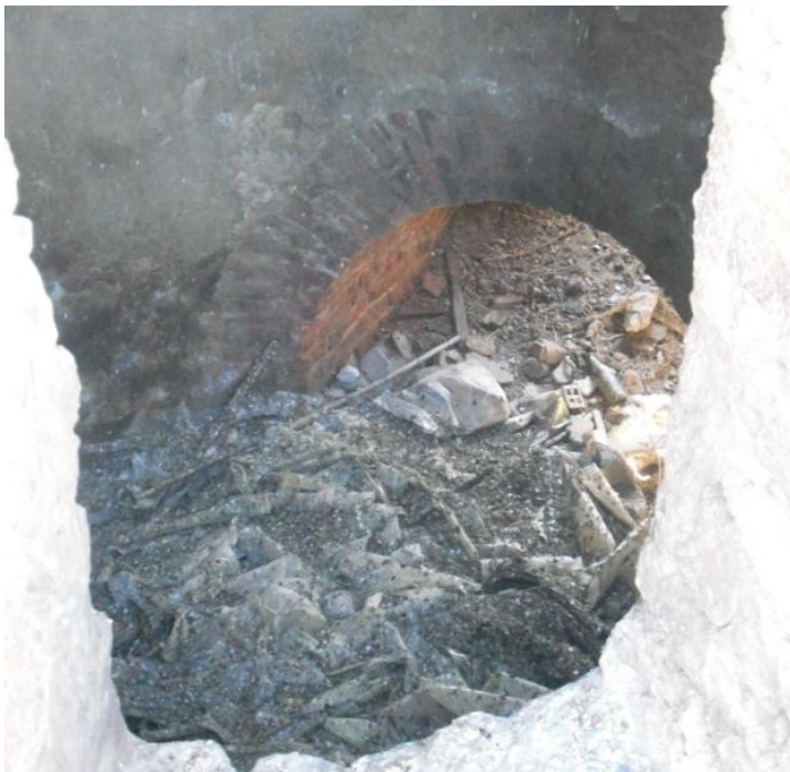
Figura 1.107. Cámara de condensación bajo la Torre del Humo desde el interior en la actualidad.
