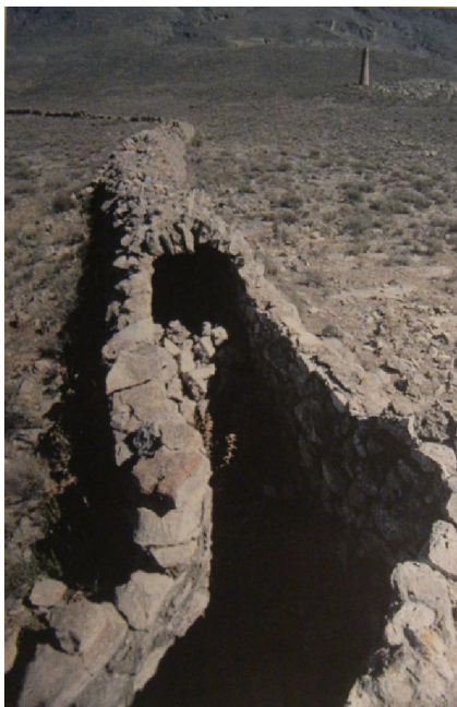
Figura 1. 5. Galería serpenteante por los montes en plan Sierra de Gádor. La Minería de Sierra de Gádor, Nuestro Legado, 2002
