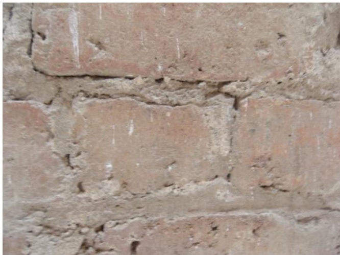
Figura 1.85. Detalle de los ladrillos de la fachada de la Torre de los Perdigones en la actualidad.
