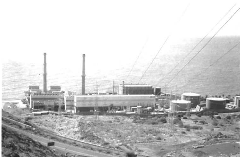
Foto 2. Central térmica Las Caletillas. Tenerife. Endesa.
