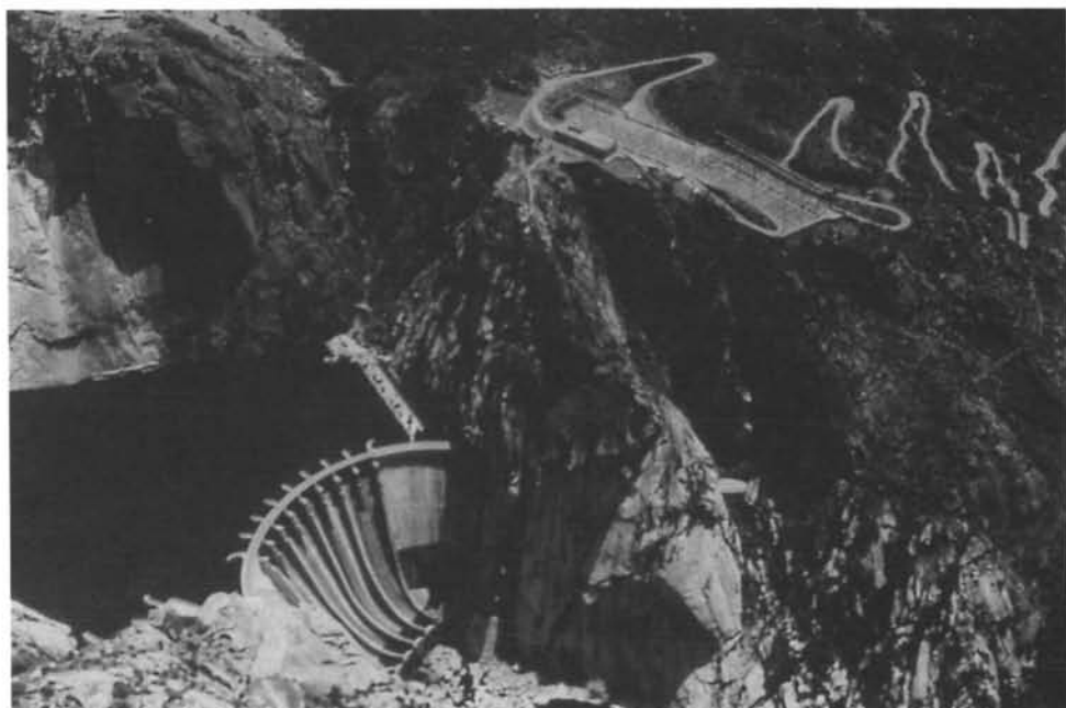
Foto 3. Central hidroeléctrica Aldeadávila. Salamanca. Iberdrola.
