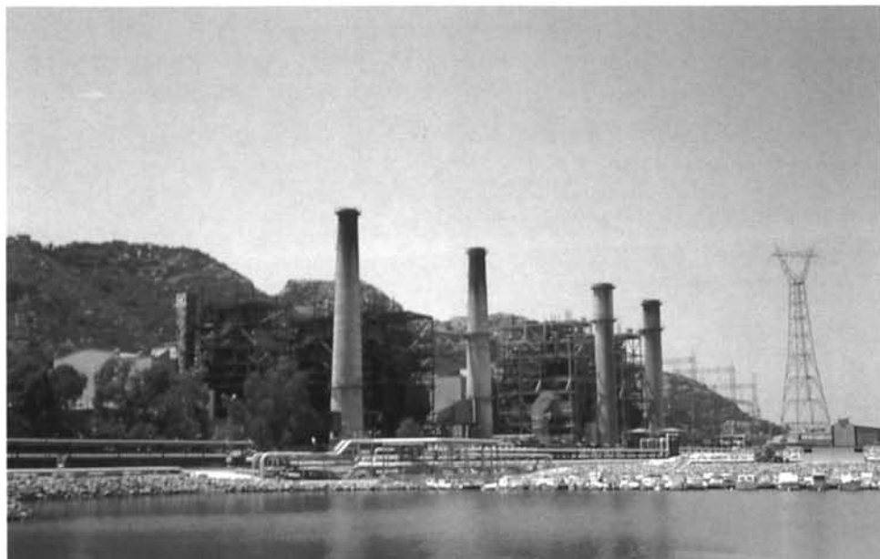
Foto 5. Central térmica de Escombreras. Murcia. Iberdrola.
