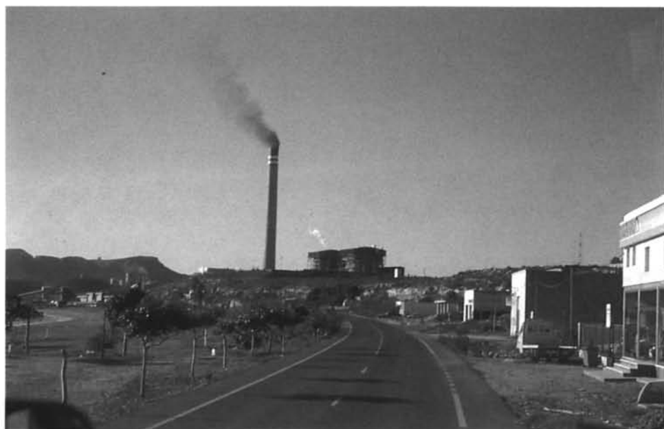
Foto 1. Central térmica Litoral de Almería. Endesa.
