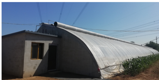
Figura 1: Invernadero solar en Pekín, China.
