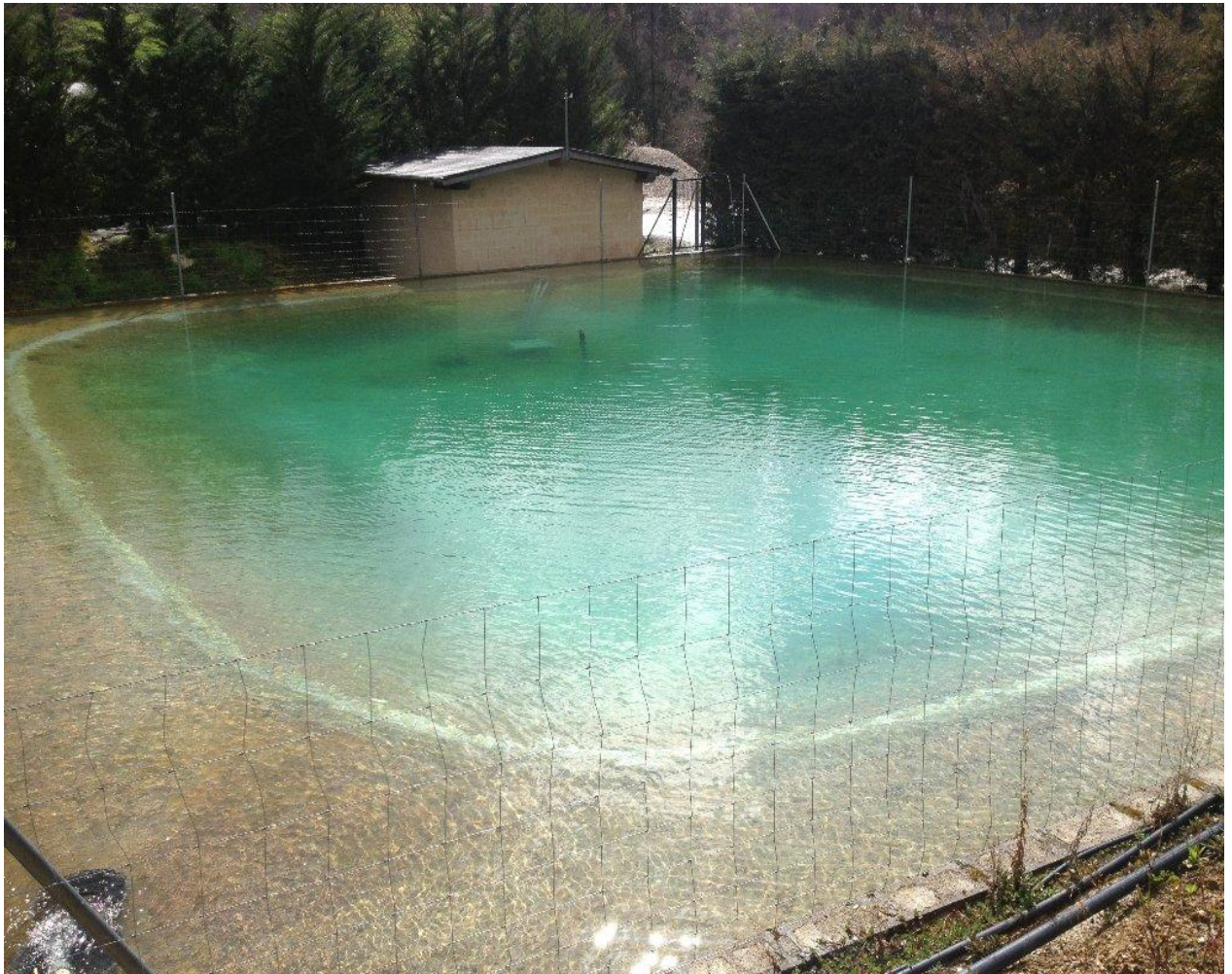
Fotografía 4. Embalse de hormigón.
