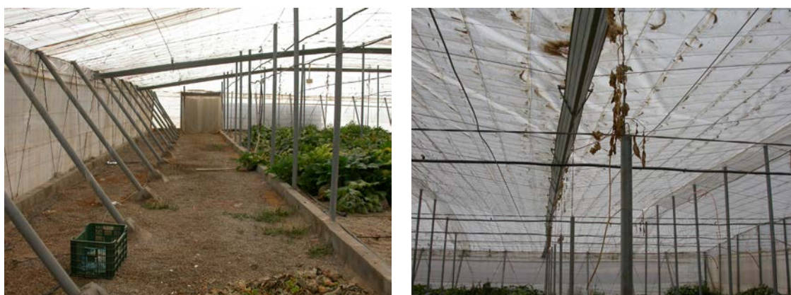
. Detalle de la estructura del interior del invernadero (izquierda) y de las canaletas de chapa galvanizada (derecha).
