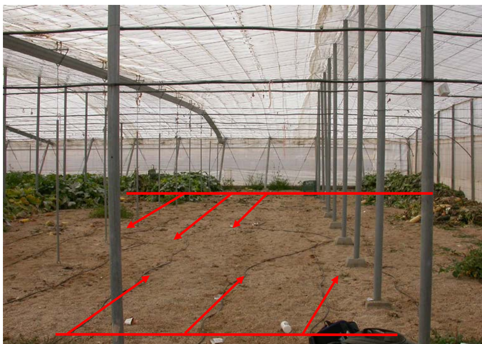
Figura 20. Detalle de la red de tuberías utilizadas para la distribución del agua de riego.
