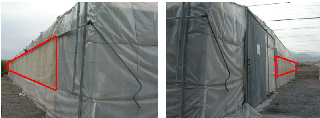
Figura 18. Vista de las ventanas lateral y frontal y de su sistema de apertura/cierre.
