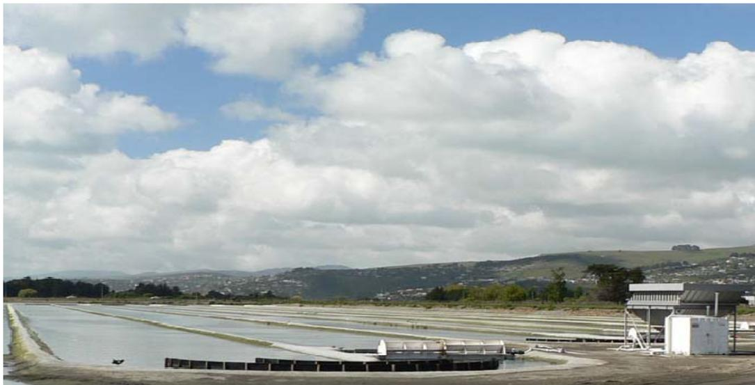
**Figura 4.** Fotografía de uno de los cuatro reactores raceway de la planta de tratamiento de aguas residuales de Christchurch
