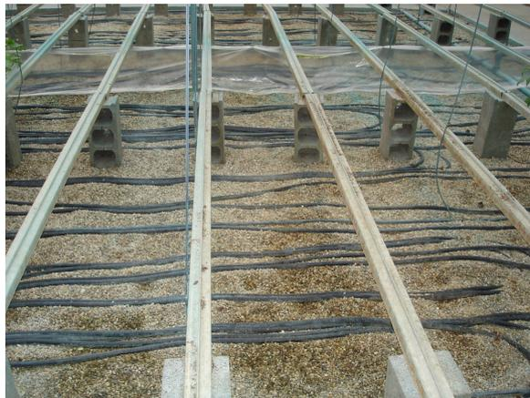
*Figura 38. Detalle de tubos corrugados de agua caliente.*
