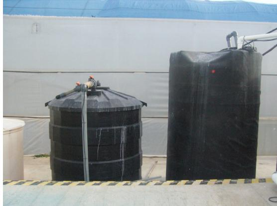
*Figura 47. Detalle de los depósitos de almacenamiento de agua de riego.*
