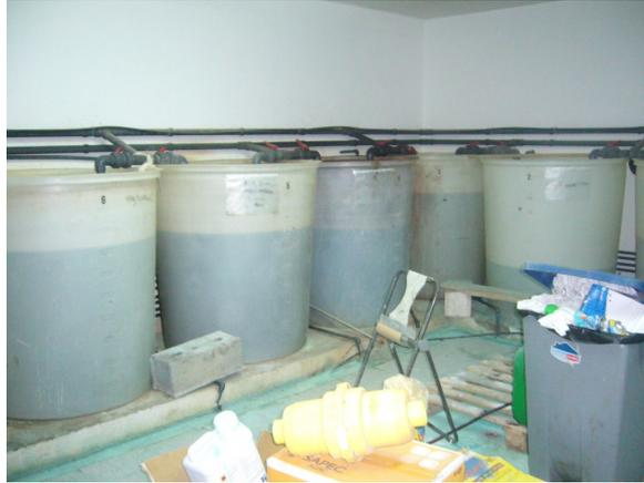
*Figura 46. Detalle de los tanques de fertilización.*
