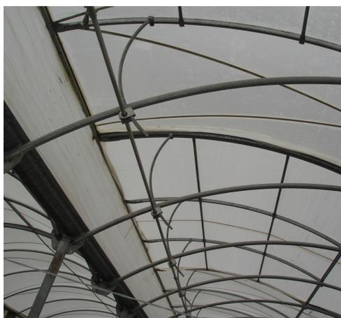
*Figura37. Detalle de una ventana abatible abierta.*
