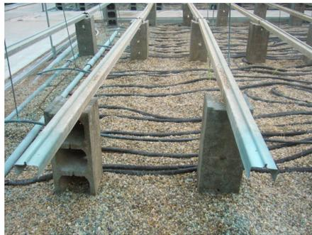
*Figura 22. Detalle de una banqueta de cultivo de viguetas galvanizadas sobre bloques de hormigón*
