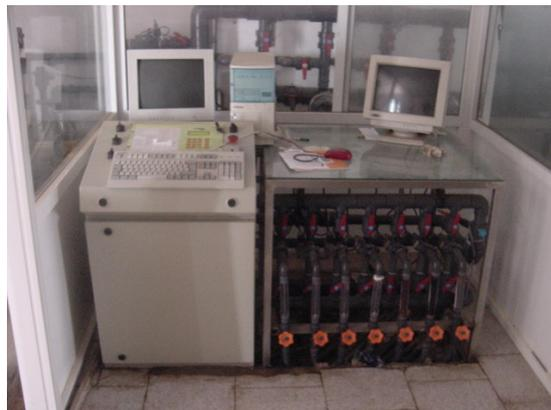
*Figura 48. Detalle de la caja de control y del ordenador de riego.*
