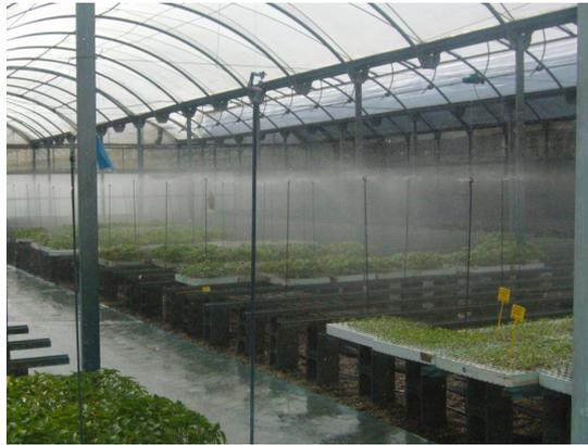
*Figura 49. Detalle de los microaspersores en funcionamiento.*
