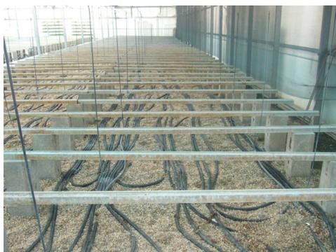
*Figura 26. Detalle de una red de tuberías corrugadas de agua caliente*
