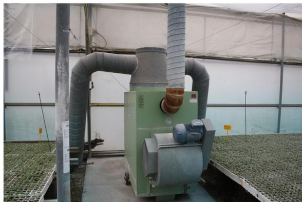
*Figura 39. Detalle del calefactor de propano*
