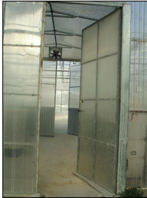
Figura 14. Detalle de la puerta de doble cierre instalada en los invernaderos.
