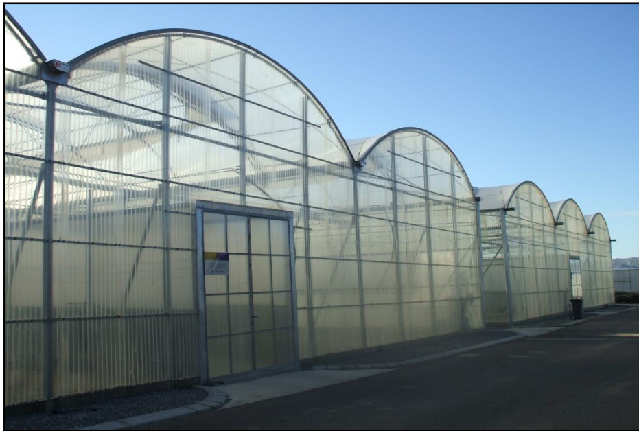
Figura 8. Detalle de la fachada oeste de los invernaderos tipo “multitúnel” utilizados en el ensayo.
