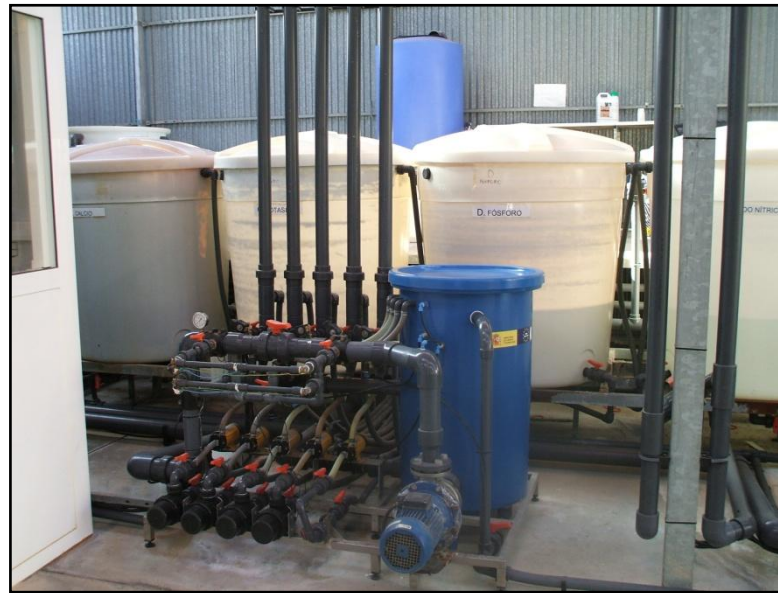
Figura 16. Detalle del cabezal de riego
