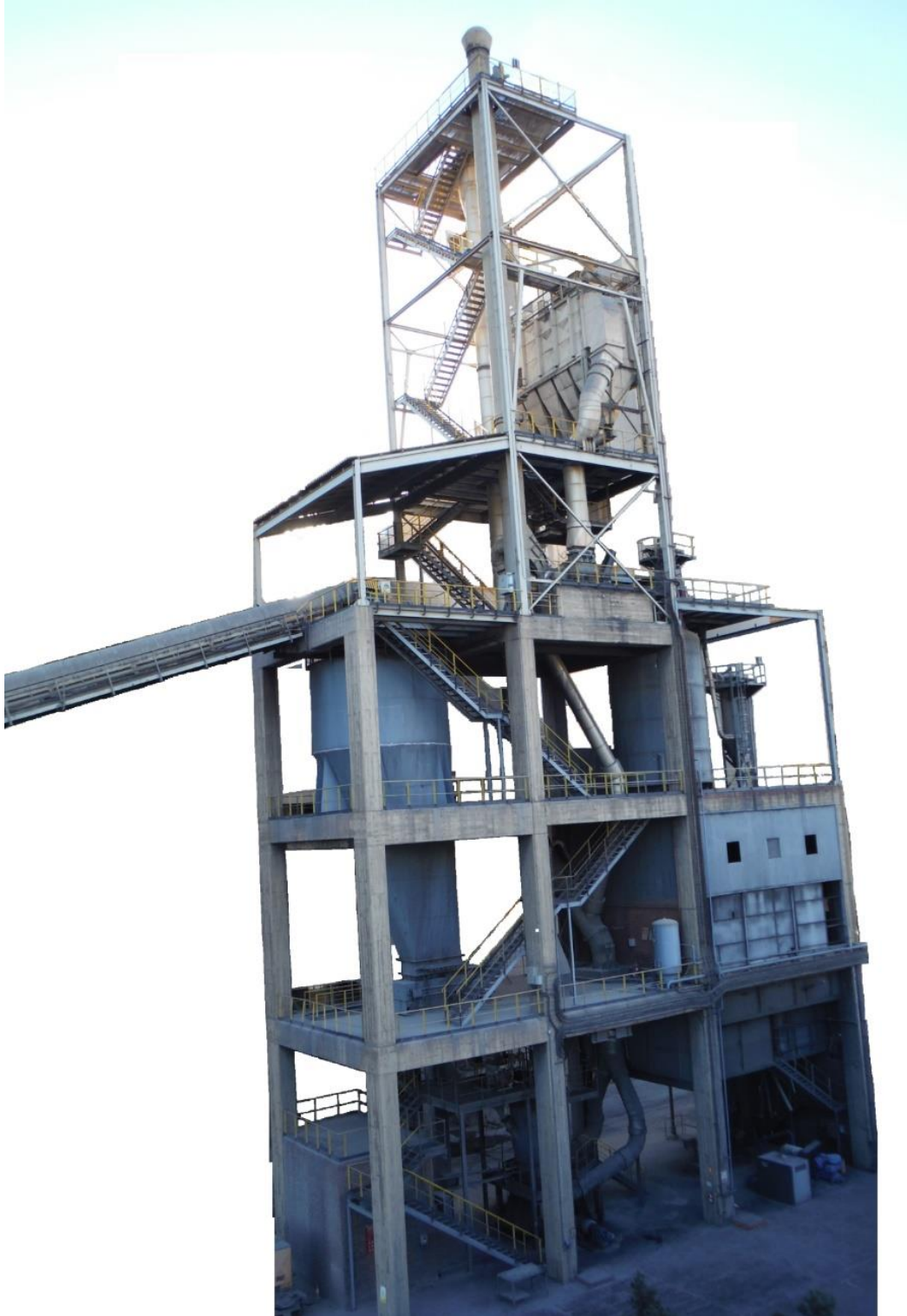
Figura 1.1. Detalle de la instalación de la molienda de carbón en la Fábrica de Cemento de Gádor en Almería.
