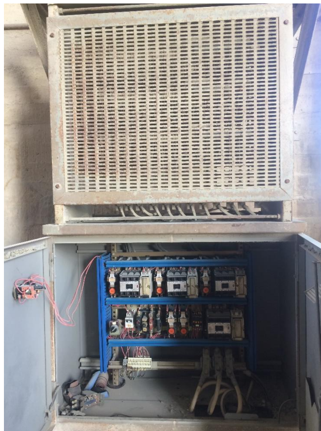
Figura 6.2. Arrancador rotórico resistivo.
