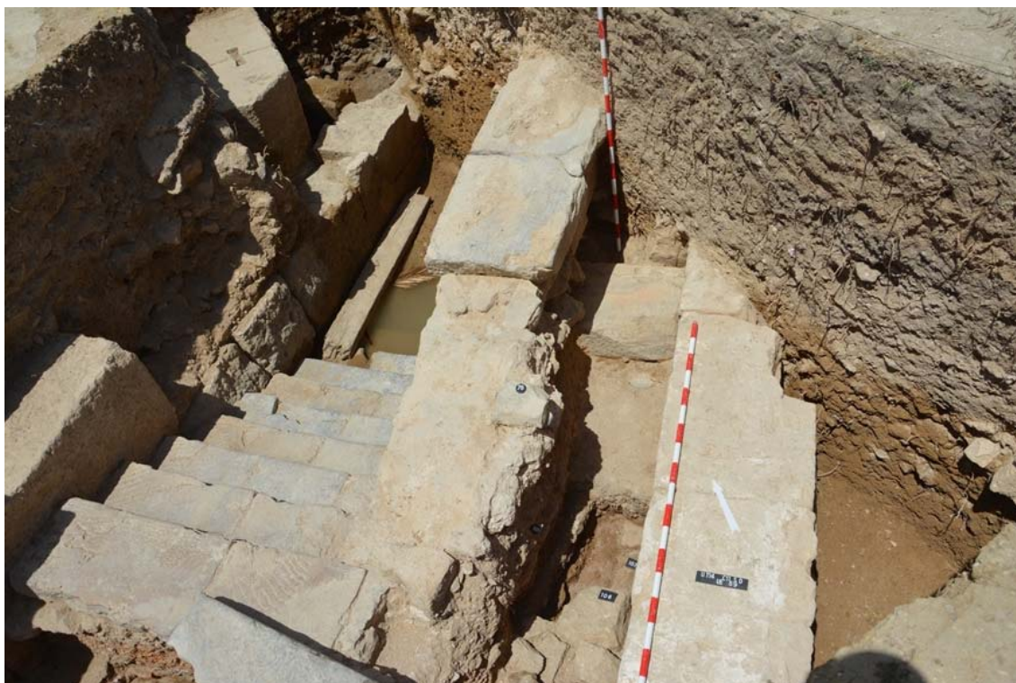
Fig. 35. Estrechamiento de la escalera mediante el muro 11078
