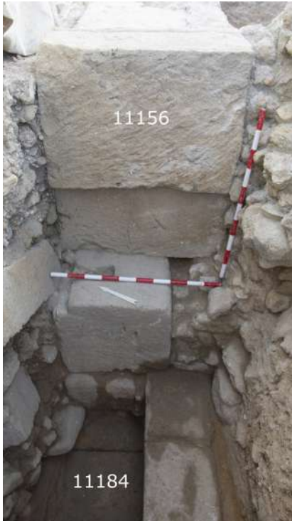
Figure 15. Le mur 11156 coupé par la citerne romaine et le mur 11184 à l'angle nord-ouest du deuxième temple.
