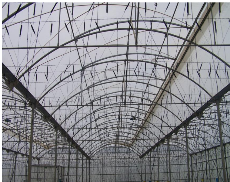
Figura 31. Detalle del techo tipo arco y de la cubierta plástica.
