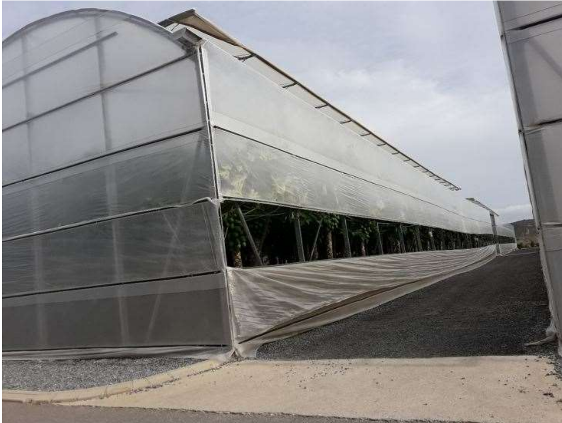
Figura 5. Vista lateral de los invernaderos U3 y U4 en la finca experimental UAL-ANECOOP, con parte de las bandas sin protección y ventanas cenitales abiertas, 590 DDT.
