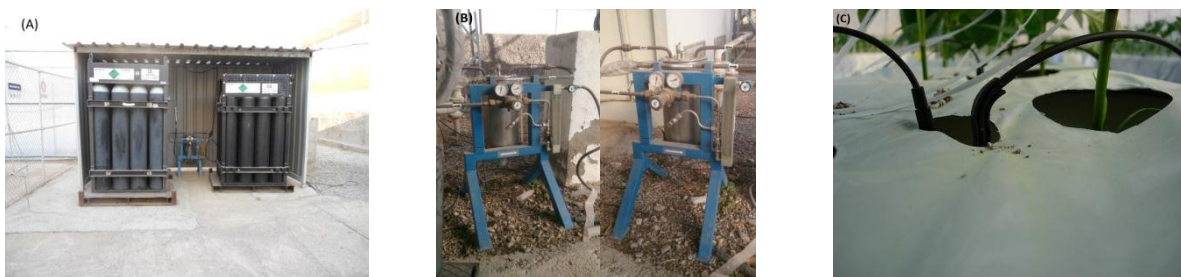
Figura 6. (A) Instalación del sistema de aporte de CO 2 y (B) detalle del descompresor y equipo calentador empleado en el sistema y (C) detalle de los emisores de CO 2 empleados junto al fertirriego.
