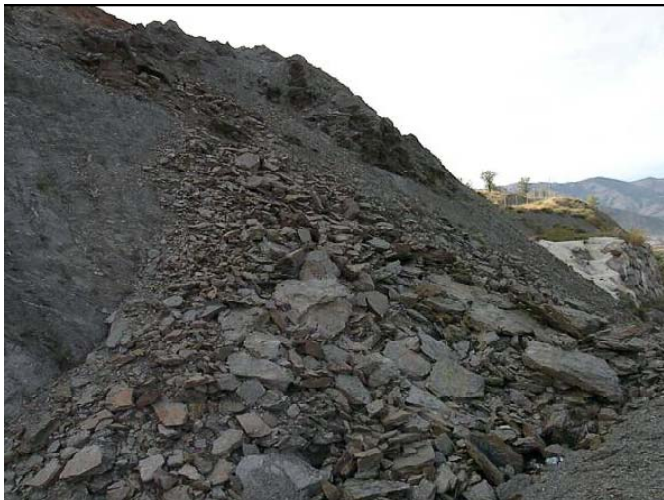
Fig 2.1.3. Deslizamiento del talud
