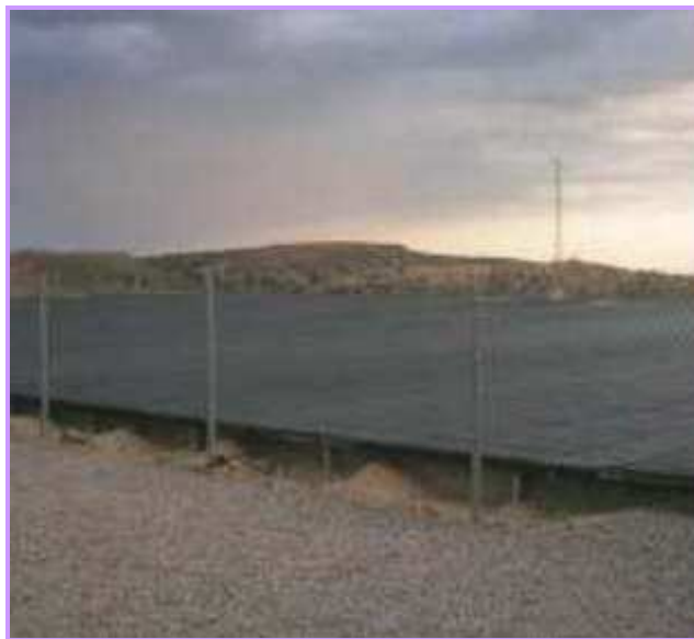
Figura 59. Detalle de balsa cubierta con geotextil negro.
