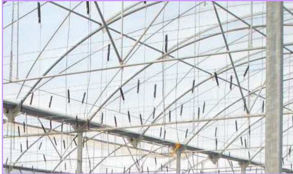
Figura 63. Detalle de las cintas de protección de la cubierta.
