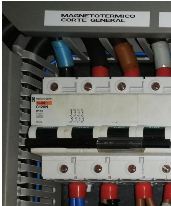
Ilustración 49. Interruptor magnetotérmico tetrapolar subcuadro piscinas
