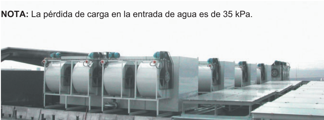
Conjunto de torres de refrigeración APAREL: cuatro del modelo TC-430 RS y una TC-450 RS.
