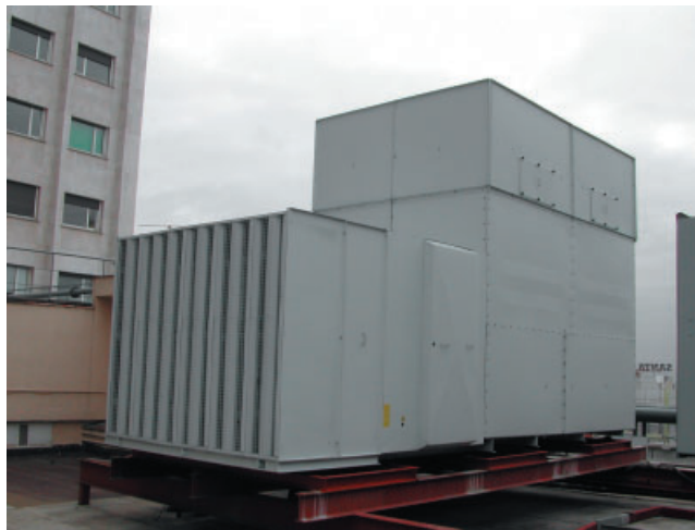
Torre de refrigeración APAREL modelo TC-265 INOX con silenciadores en aspiración e impulsión.
