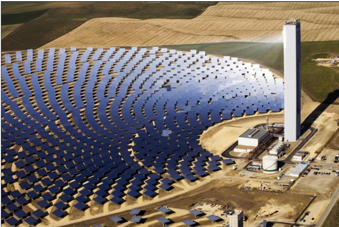
Figura 2.4. Ejemplo de la tecnología CSP de torre central [18].
