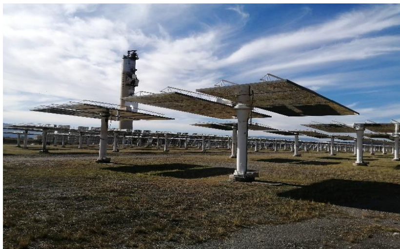
Figura 2.1. Planta de tecnología de receptor central. CESA-PSA [Cortesía de PSA].
