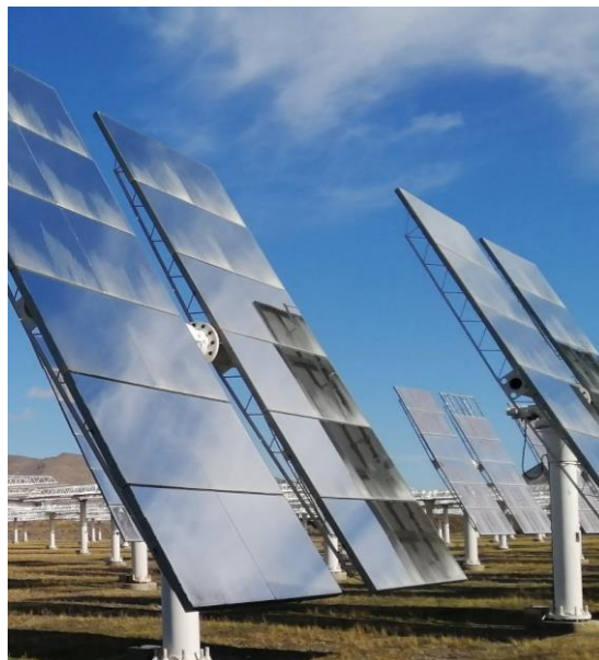
Figura 2.13. Facetas y estructura soporte de un heliostato de la PSA [Cortesía de la PSA].
