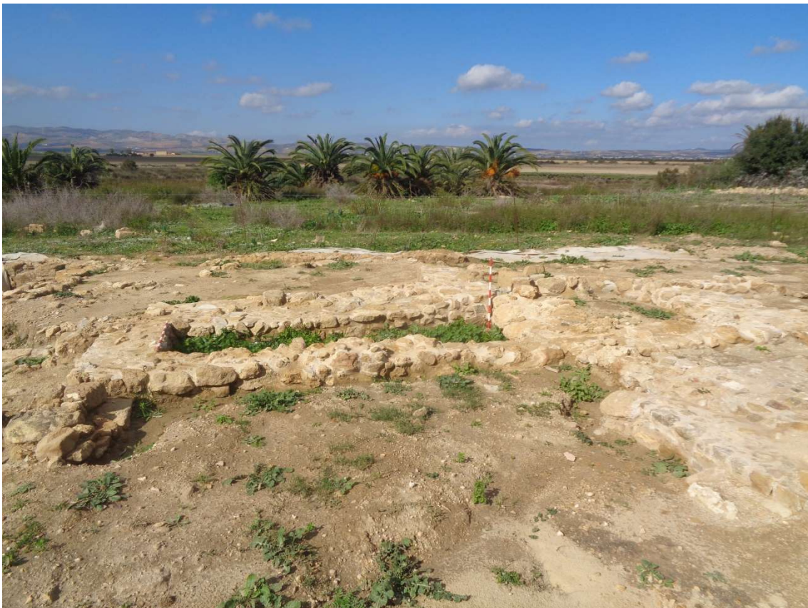
Fig. 50. Vista de las estructuras del corte 10 tras los trabajos de consolidación
