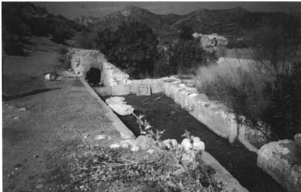
Fig. 10.- Salida de la galería y abrevadero en la margen derecha de la Rambla de Béjar.
