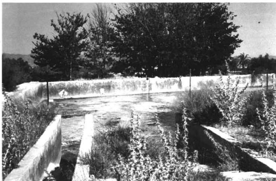
Fig. 11.- Balsa donde se acumulan las aguas captadas por la galería drenante adosada a presa subálvea en la Rambla de Béjar.
