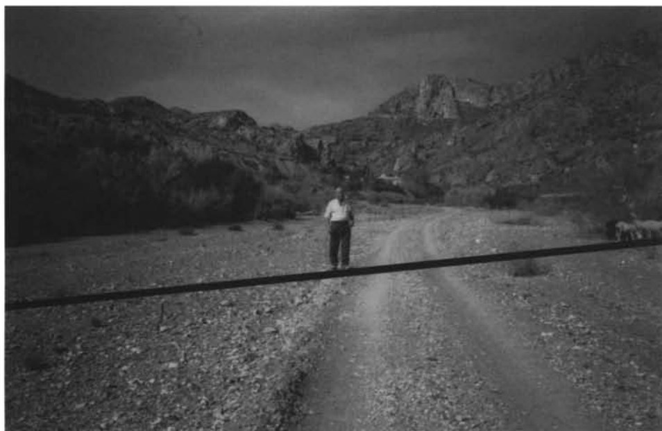
Fig. 9.- Situación de la galería drenante adosada a la presa subálvea enterrada en la Rambla de Béjar.
