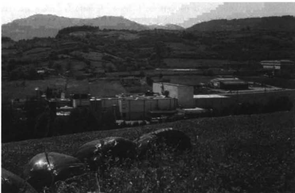
Fig. 4. La fábrica de Danone (en el centro de la imagen) comparte su emplazamiento con explotaciones agrarias y con una serie de instalaciones industriales y de servicios que han encontrado en el fondo de valle del río Nonaya el espacio idóneo para su actividad, principalmente debido a la necesidad de suelo que ésta conlleva: los talleres municipales y los equipamientos escolares y deportivos de la villa (en último plano, a la derecha).
