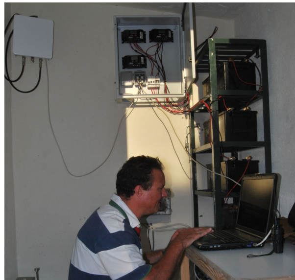
Figura 23. Comprobando la alineación de la antena de Sierra Filabres.
