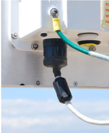
Figura 27. Impermeabilizando con cinta vulcanizable.
