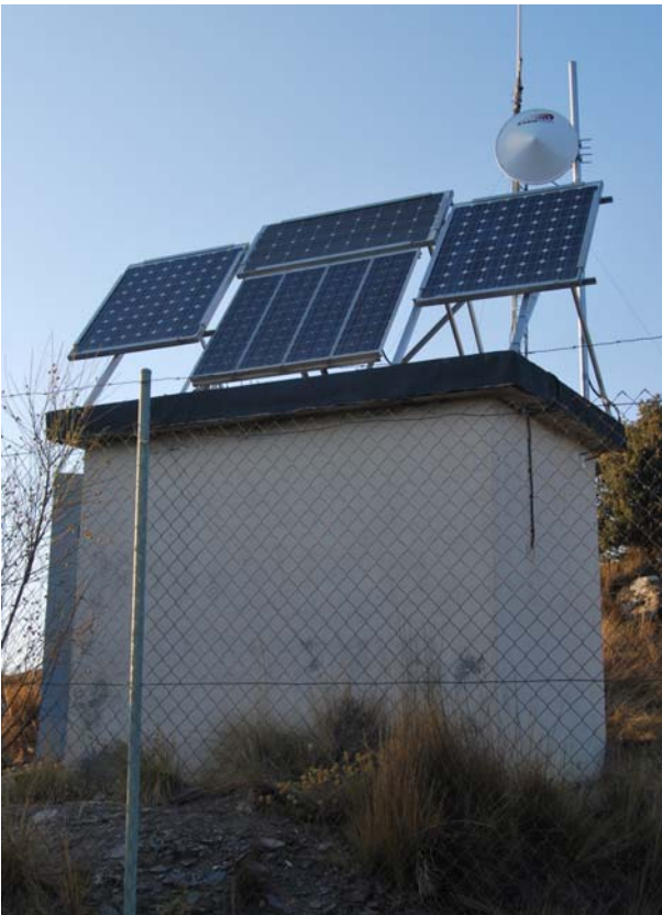
Figura 1. Estación de captación de medidas sísmicas y de señales electromagnéticas de baja frecuencia de Sierra de los Filabres.
