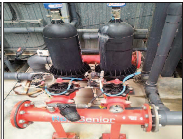
Figura 30. Filtros de anillas
