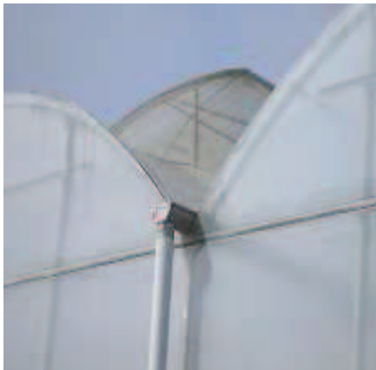
Figura 25 . Vista de las ventanas supercentrales.
