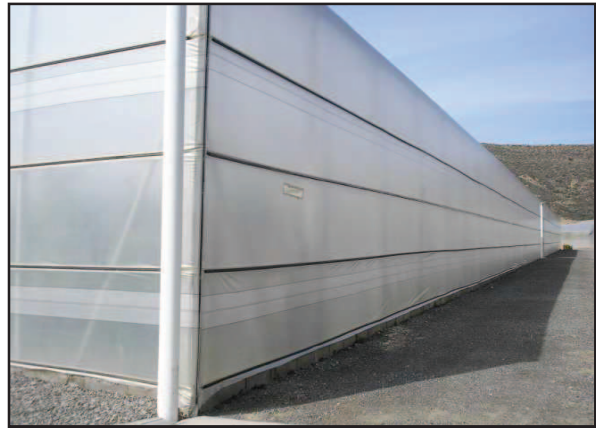
Figura 24. Vista lateral del invernadero.
