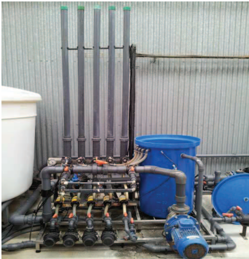
Figura 31. Tanque de mezcla de fertilizantes.
