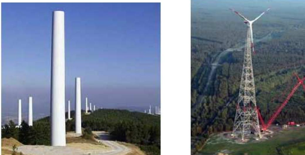
Figura 2.21. Torre de acero tubular (izquierda) y torre de celosía (derecha)
