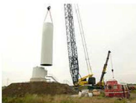
Figura 2.22. Izamiento de torre tubular de acero
