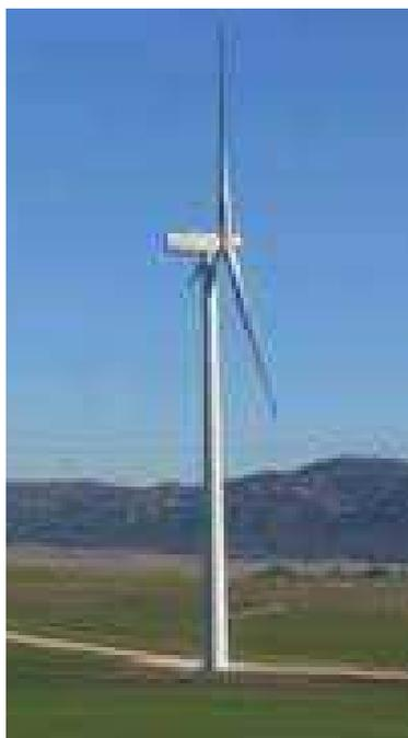
Figura 2.31. Aerogenerador de eje horizontal
