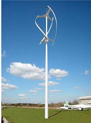
Figura 2.28. Aerogenerador de eje vertical
