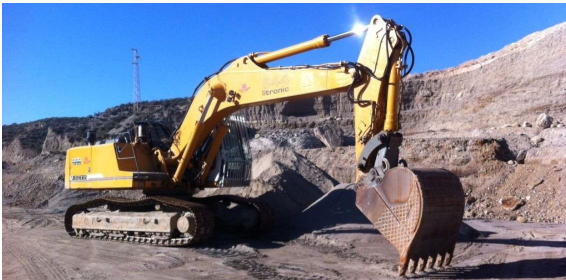
Imagen 1. Detalle de la retroexcavadora.
