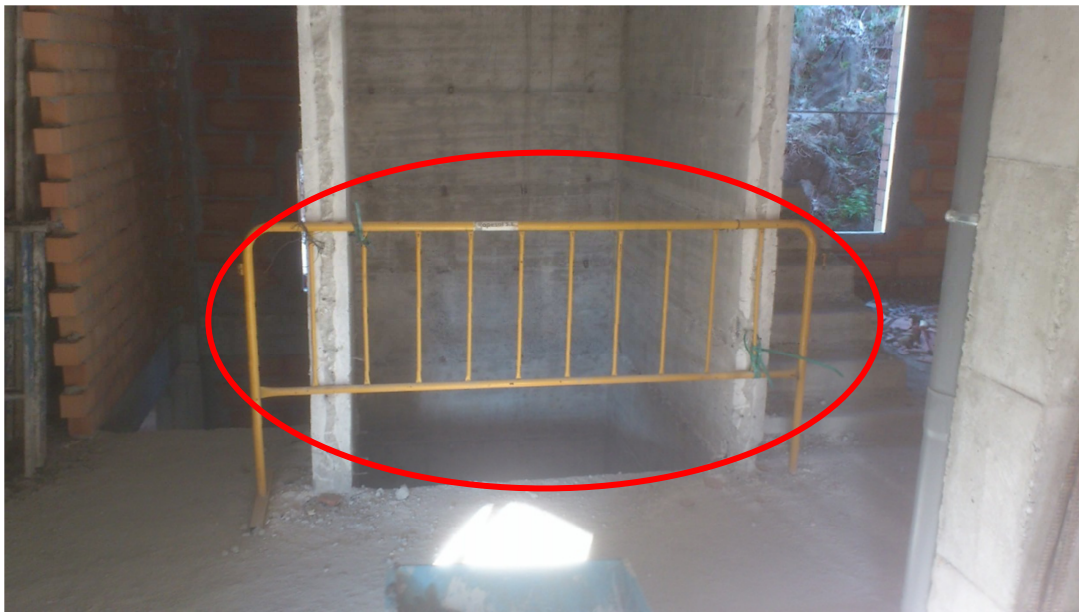
Ilustración 9: "uso de valla en lugar de barandillas para tapar hueco del ascensor"
