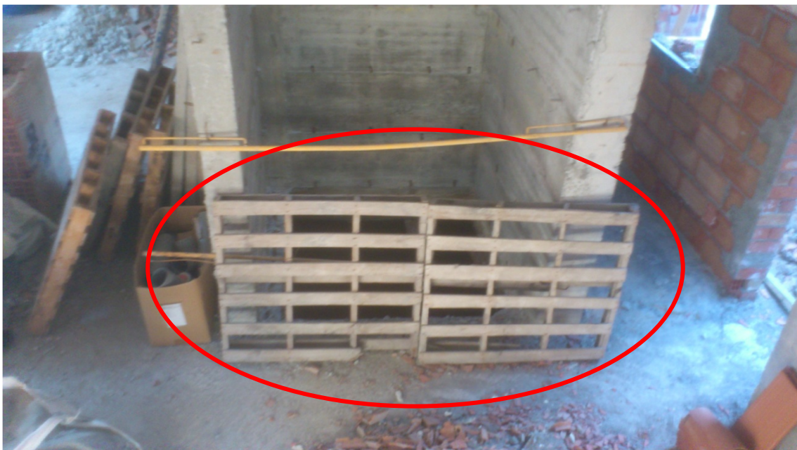
Ilustración 10: "palets usados para tapar hueco de ascensor"
