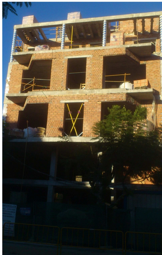
Ilustración 1: "vista general de la obra"
