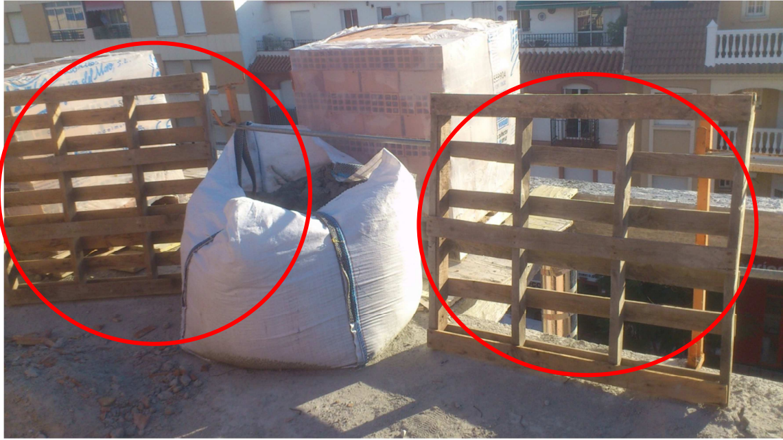
Ilustración 11: "palets usados en lugar de barandilla"
