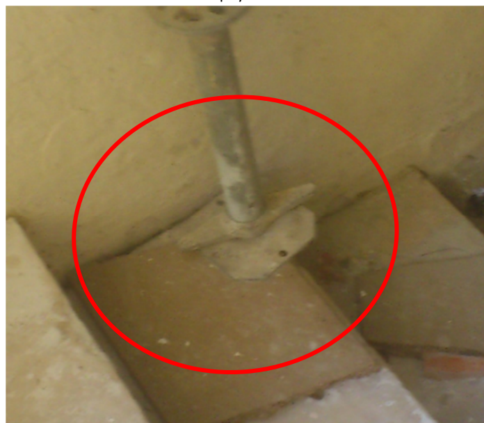
Ilustración 27: "apoyo inestable"
