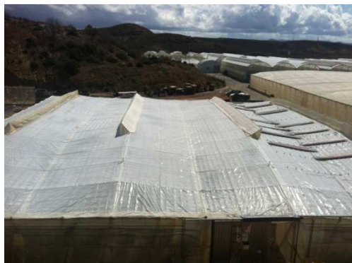
Figura 3.6. Fotografía del invernadero donde se muestra la ventilación cenital automática.
