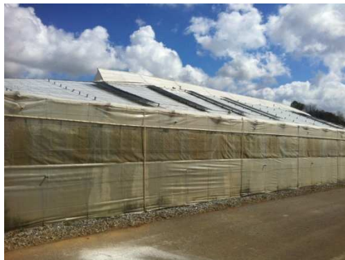
Figura 3.5. Fotografía del invernadero donde se muestra la ventilación lateral automática en la zona sur.
