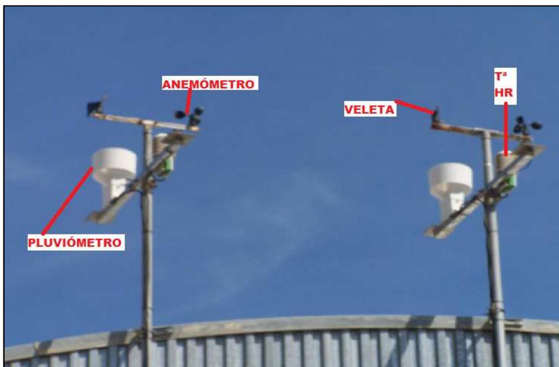
**Figura 37.**Detalle de la estación meteorológica instalada en el exterior.
