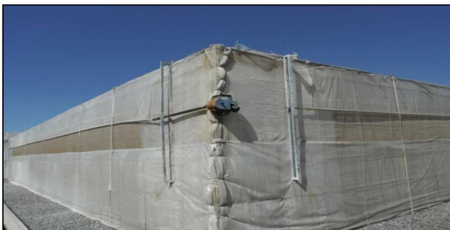
**Figura 40.**Detalle ventanas laterales.
