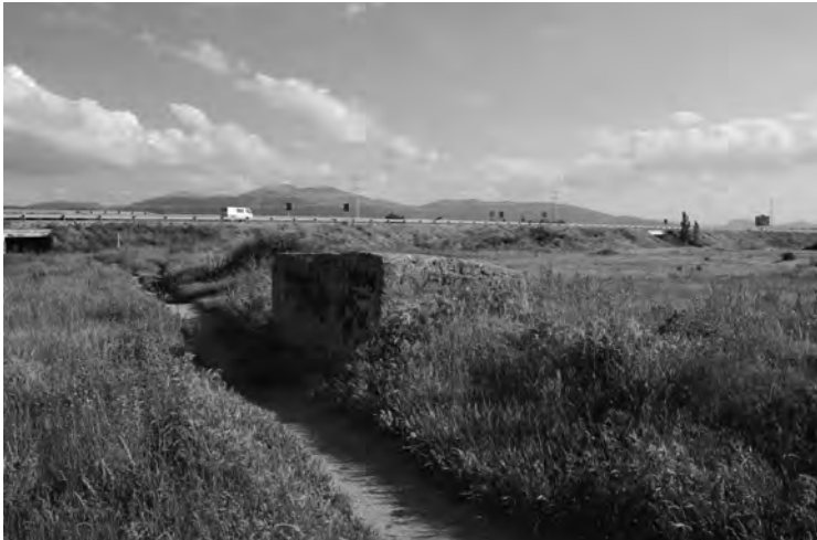
Eriales entre Nueva Segovia y la variante sur, con raqueta del acueducto en primer plano.
