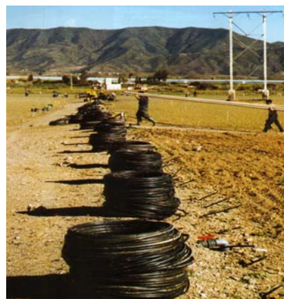
Foto 10. Tubería de Polietileno para ser utilizada en invernaderos con enarenado en Almería, España
