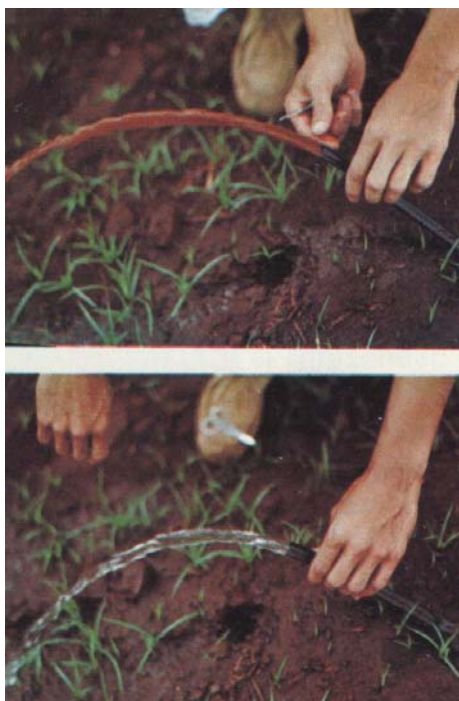
Foto 33. Drenado de líneas laterales
