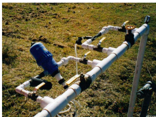
Foto 18. Combinación de inyector Venturi-Dosificador
