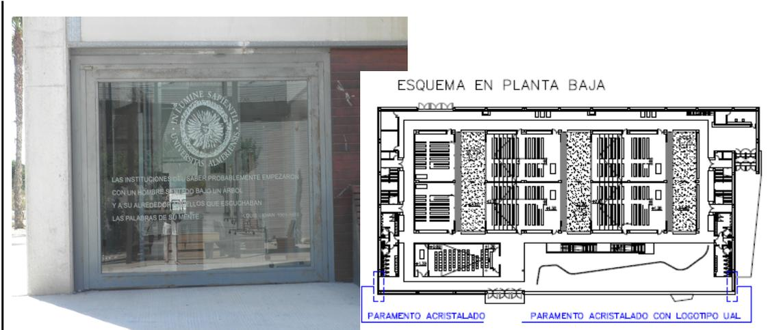
Fotografía 7: paramento vertical acristalado con logotipo al ácido fluorhídrico, tomada desde el exterior de la fachada este.
