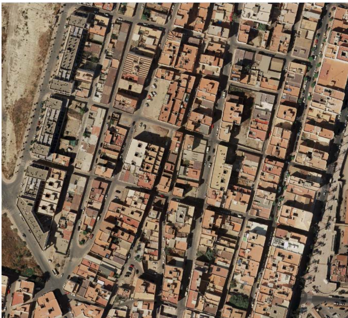
Figura 10. Zona Urbana (Población de Garrucha, Almería). Fuente: Propia
