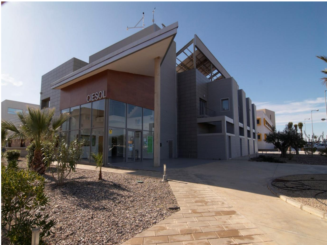
Figura 3.1. Vista exterior del C-Ddl-CIESOL-ARFRISOL.
