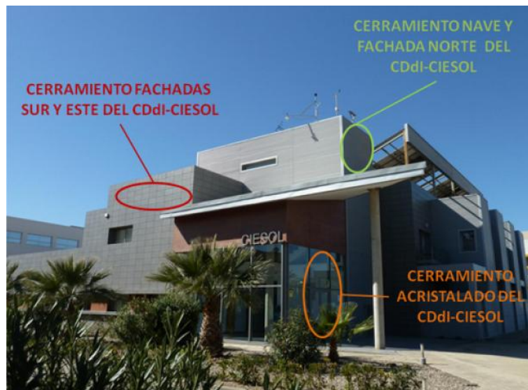
Figura 3.4. Cerramiento exterior del CDdi-CIESOL-ARFRISOL.
