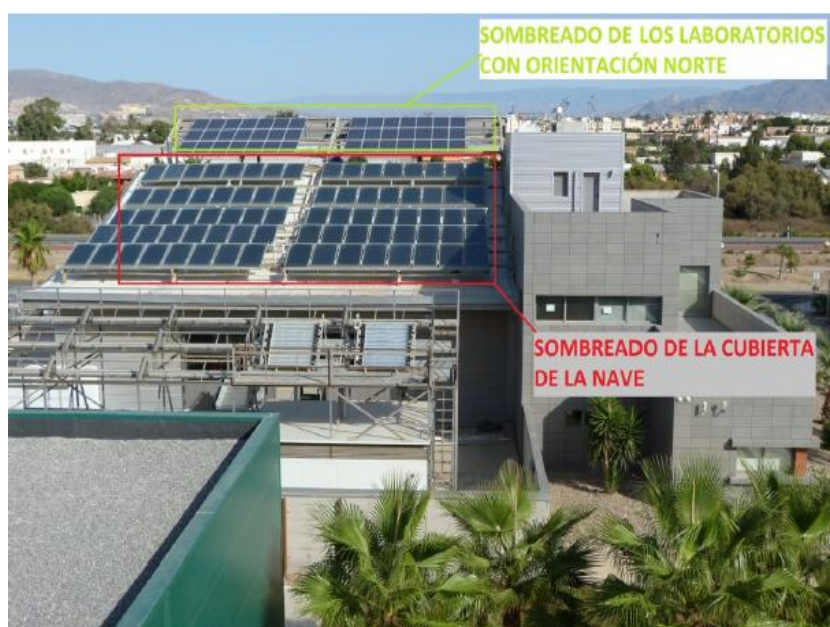
Figura 3.5. Sombreamiento de la cubierta exterior del CDdI-CIESOL-ARFRISOL.
