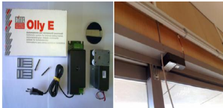
Figura 3.16. Motor instalado para apertura/cierre de ventanas.
