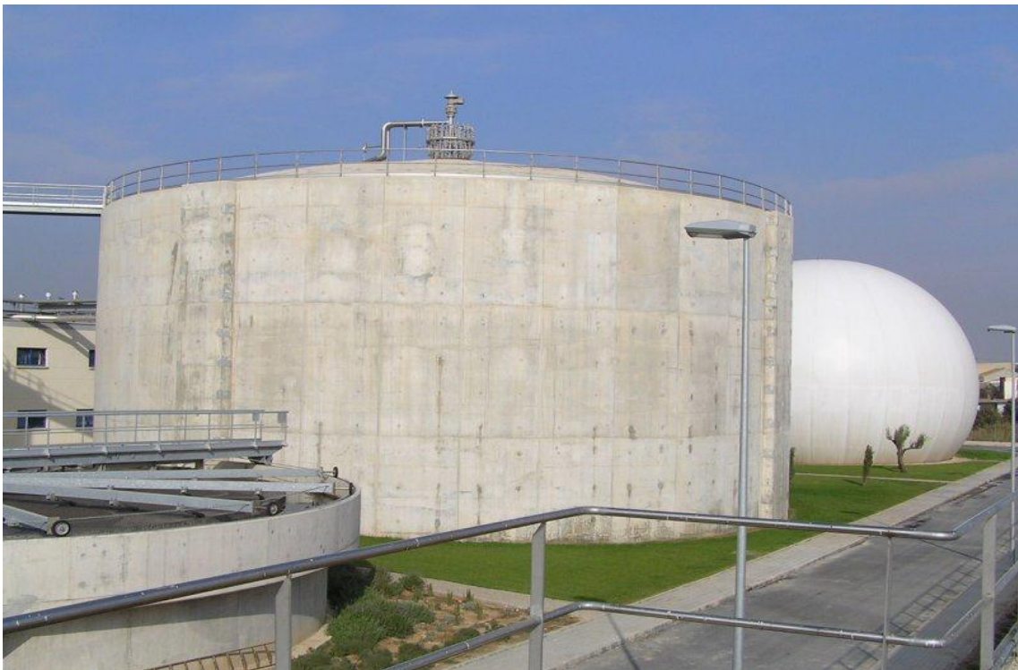
Imagen 4: Ejemplo de digester anaerobio.
