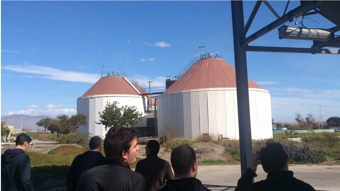
Imagen 12: Ejemplo de digester de fangos en la EDAR El Bobar, Almería
