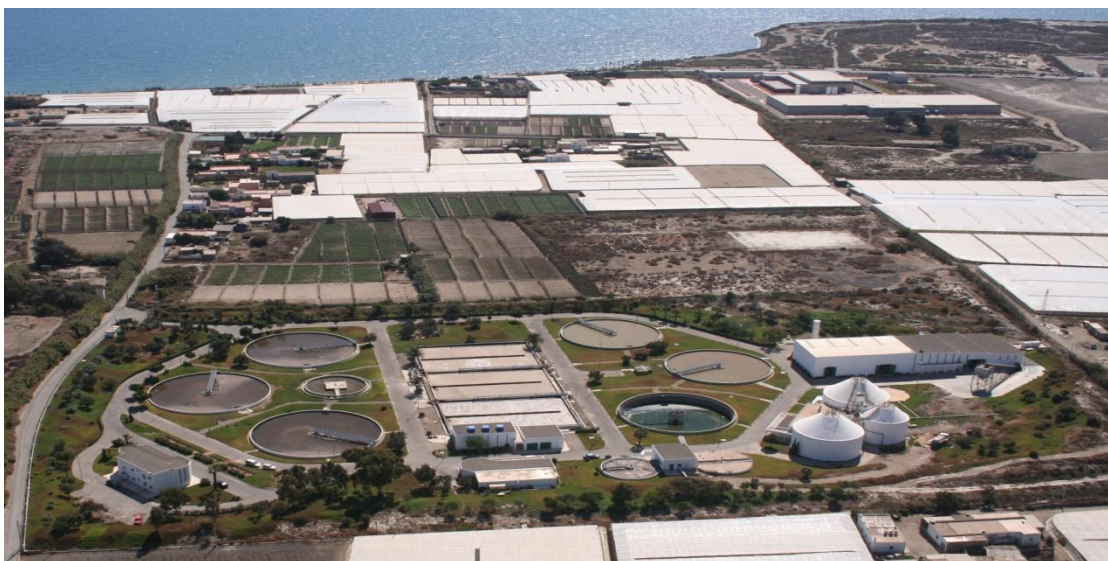
Imagen 1: Vista aérea EDAR El Bobar, (Almería).
