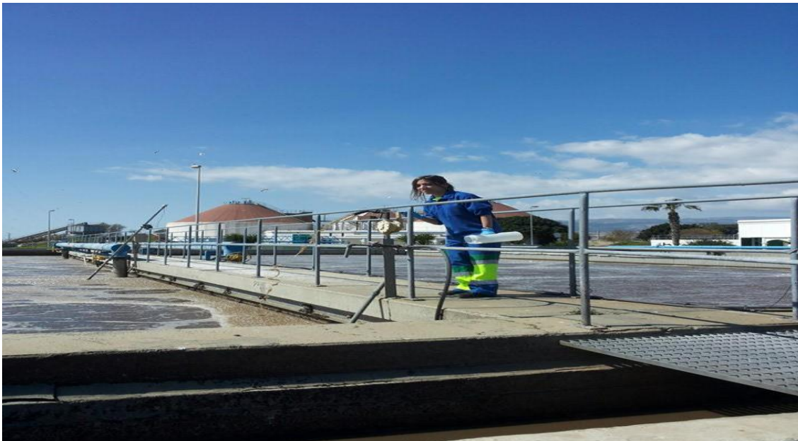
Imagen 9: Reactor biológico en EDAR EL Bobar, Almería.
