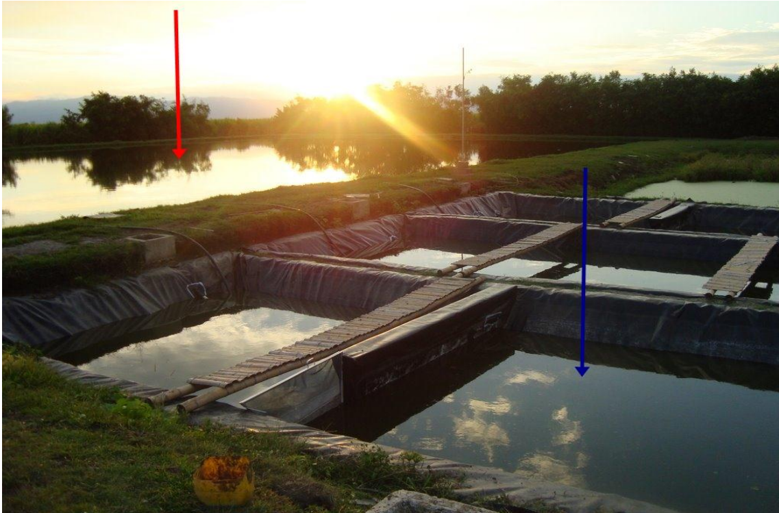
Imagen 3: Ejemplo de lagunas facultativas en Ginebra,(Colombia). La flecha azul indica pequeñas lagunas con algunas mejoras que están en fase de prueba. La flecha roja indica la laguna facultativa a tamaño real.
