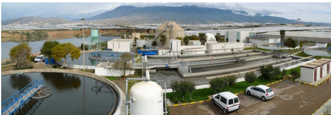
Foto 5. Instalaciones de la EDAR de El Ejido. Fuente propia
