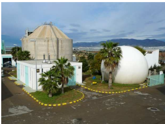
Foto 1. Línea de fangos de la EDAR El Ejido
