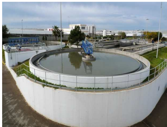
Foto 4. Decantador primario de la EDAR El Ejido
