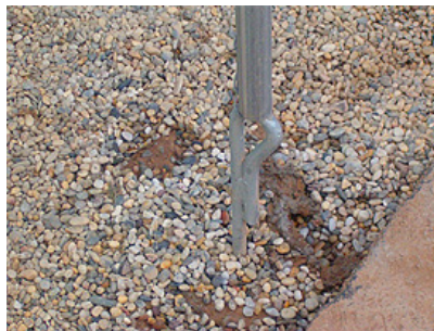
Figura 6: Cabilla de acero de la cimentación de un amagado (Fuente: www.villegasmoreno.com )
