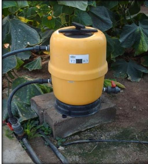
*Figura 3.1.8. Abonadora para la distribución del fertilizante de cada bloque.*
