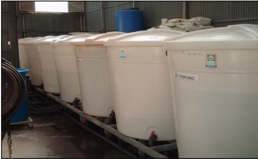
*Figura 3.1.7. Vista de los tanques de 1000 l del cabezal de riego.*
