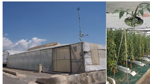
Figura 3: Instalaciones del invernadero. Desde la izquierda hacia la derecha y desde arriba hacia abajo: invernadero, pipeta de riego y líneas de cultivo de tomates.
