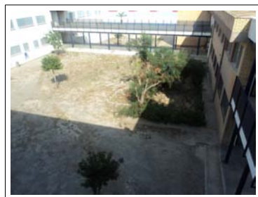
Estado actual de uno de los patios a reformar
