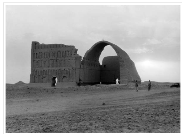
El palacio de Tesifonte en 1932
