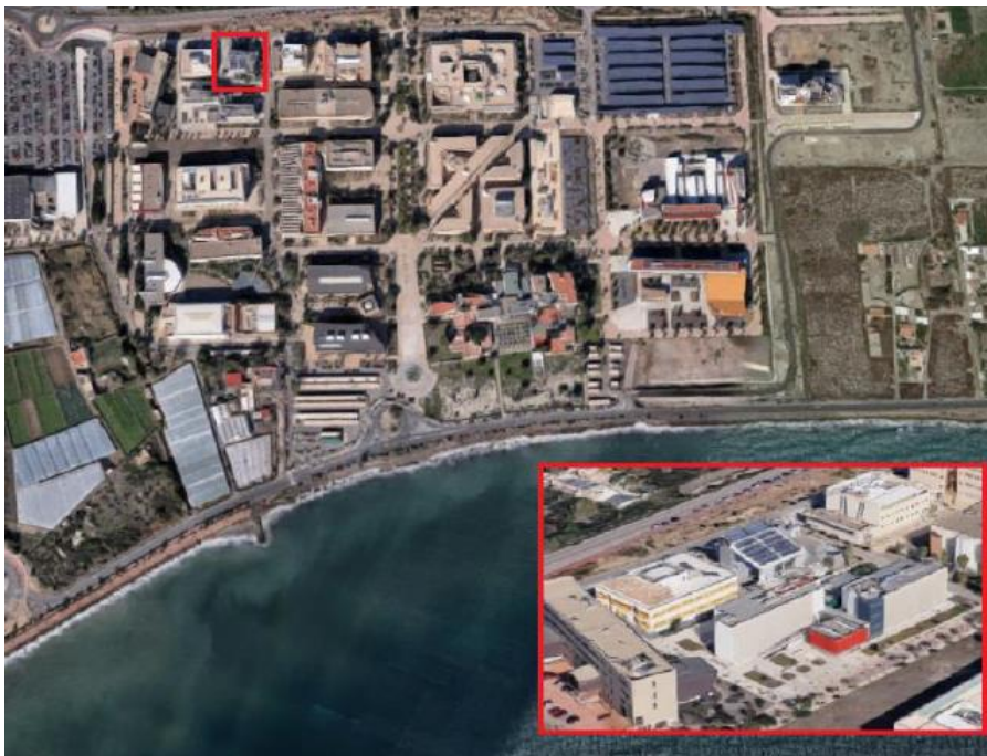
Figura 3.1 Localización del edificio C-DdI-CIESOL-ARFRISOL
