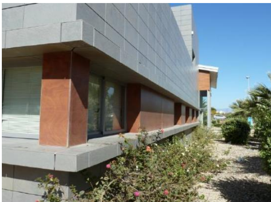
Figura 3.3 Retranqueo de las ventanas con orientación este y sur
