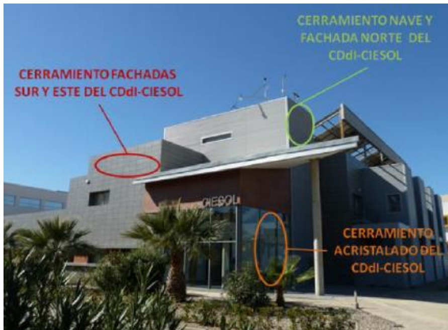
Figura 3.4 Cerramiento exterior del edificio
