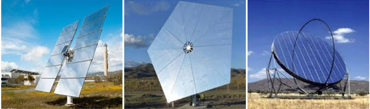
Figura 9: De izquierda a derecha ejemplos de: heliostato facetado con forma rectangular, facetado con forma pentagonal, y de membrana tensionada.
