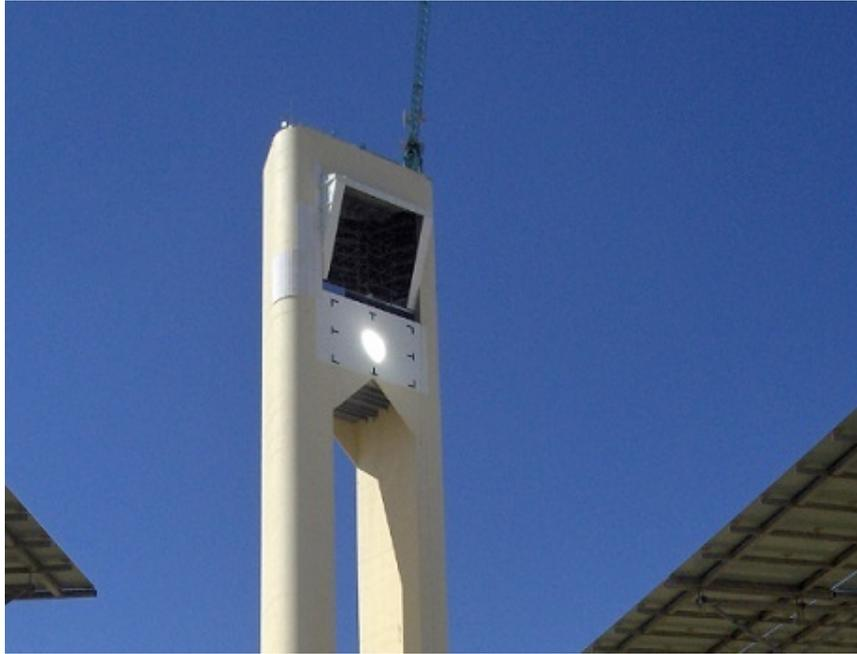
Figura 12: Receptor de cavidad de la planta *PS10* (España), en el que calienta vapor de agua a  $250^{\circ}\text{C}$ - $300^{\circ}\text{C}$  . Esta planta tiene un campo de heliostatos norte.
