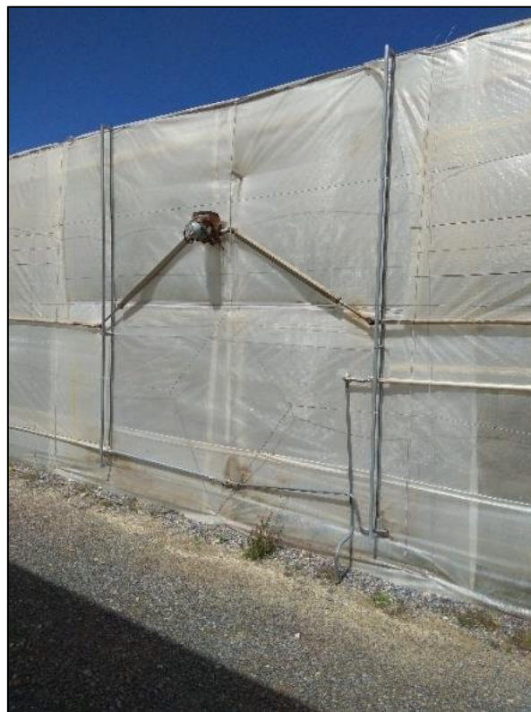
Figura 15. Imagen de las ventanas laterales en la que se aprecia la ventana inferior cerrada en el lado Oeste y abierta en el Este.
