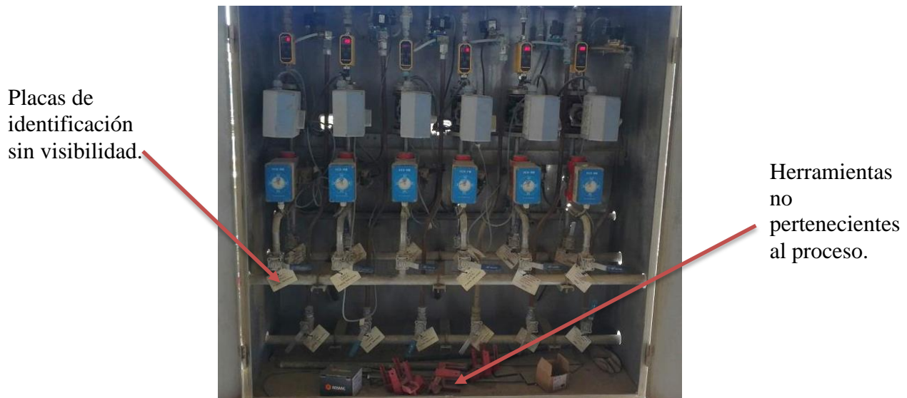
Figura 1. Instrumentación armario lanzas solución amoniacal según se observó en visita en el mes de marzo.
