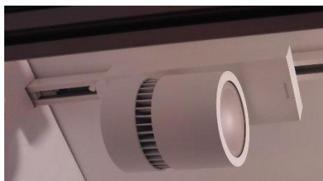
c) Lámpara LED empleada en la cámara de refrigeración.
